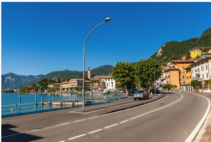
Strada 'Sebina occidentale', stanziati 250.000 euro per ripristino viabilità
