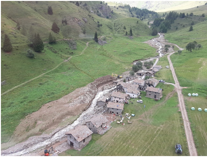
Passo Gavia, in corso lavori per messa in sicurezza Sp 29
