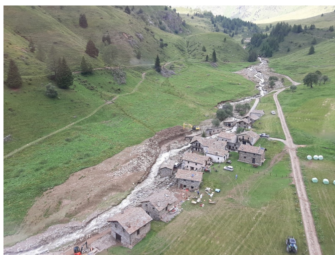
Passo Gavia, in corso lavori per messa in sicurezza Sp 29
