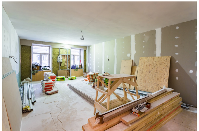
Da Regione 23 milioni per riattare alloggi per servizi abitativi sociali
