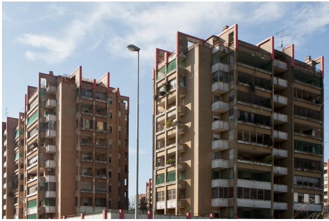
Case popolari, a settembre concluso il 92% di ristrutturazioni e recuperi
