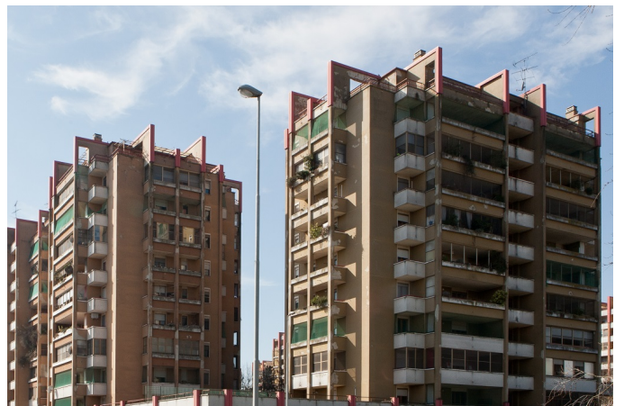
Case popolari, a settembre concluso il 92% di ristrutturazioni e recuperi
