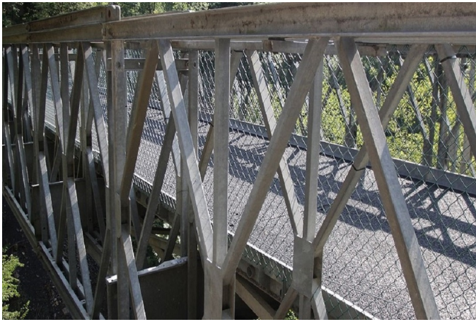
Ponte Taleggio, Terzi: 1,4 milioni per messa in sicurezza versante frana
