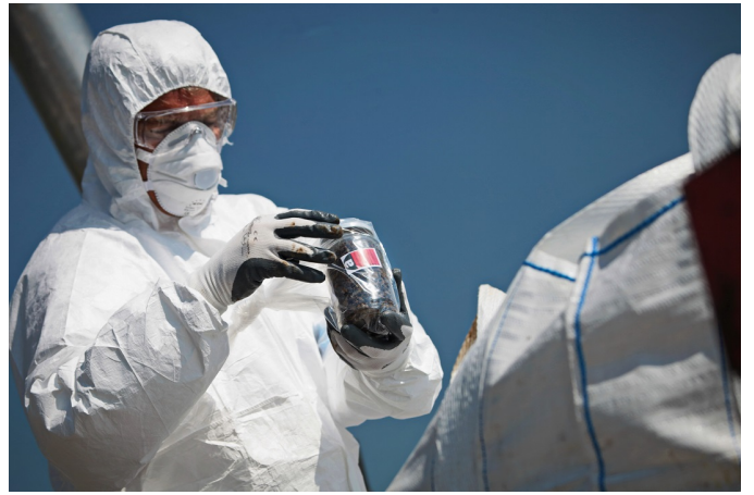
Edilizia scolastica, Rizzoli: 16 milioni per rimozione amianto da istituti
