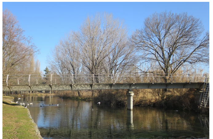
Tangenziale Goito, infrastruttura finanziata da Regione con 130 milioni
