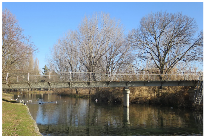
Tangenziale Goito, infrastruttura finanziata da Regione con 130 milioni
