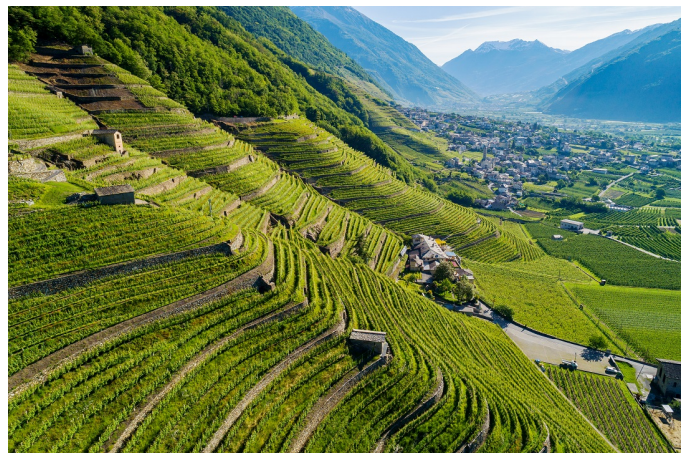
Montagna, Sertori-Rolfi: oltre 4,6 milioni per Bando Terrazzamenti 2020
