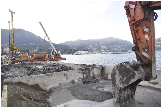
Paratie Como, Fontana e Sertori in sopralluogo al cantiere
