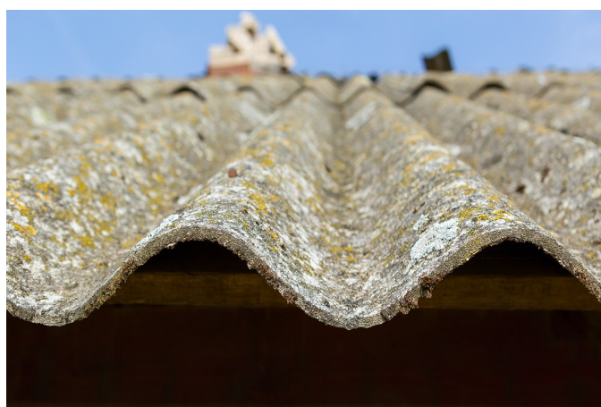
Rimozione amianto da edifici pubblici, Cattaneo: 10 milioni a Enti locali
