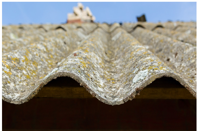
Rimozione amianto da edifici pubblici, Cattaneo: 10 milioni a Enti locali
