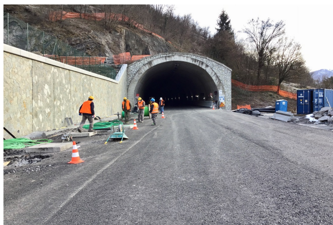
Variante di Zogno (Bg), Terzi: procede il cantiere finanziato da Regione - video
