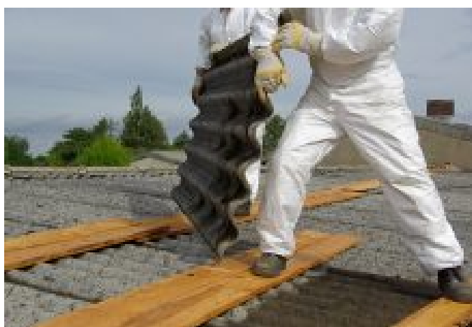
Rimozione amianto da edifici privati, Cattaneo: al via bando da 1...
