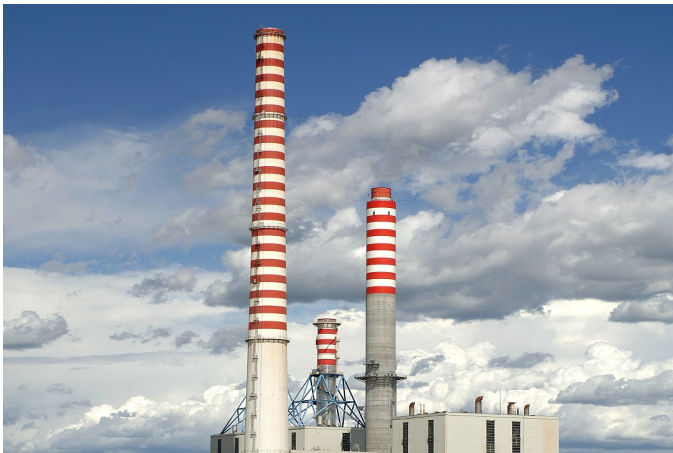
Ostiglia, ampliamento centrale termoelettrica. Cattaneo: procedura nazionale
