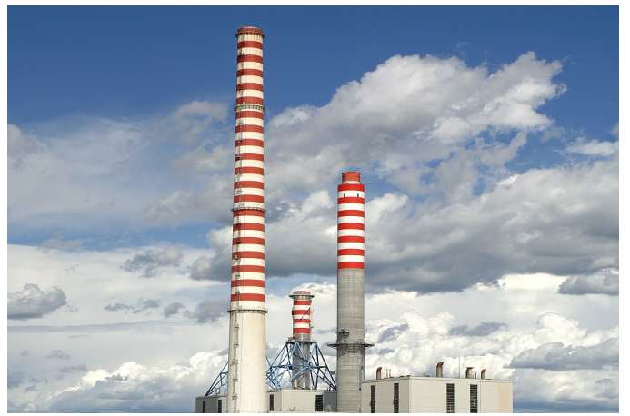
Ostiglia, ampliamento centrale termoelettrica. Cattaneo: procedura nazionale
