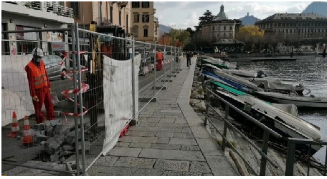
Paratie, lavori avanzano nonostante la zona rossa come da cronoprogramma
