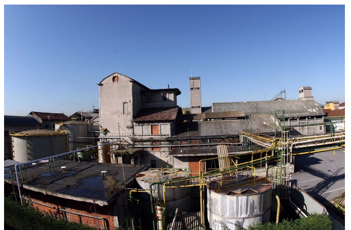
Caffaro/Bs Tavolo in Regione: barriera idraulica e misure di contenimento
